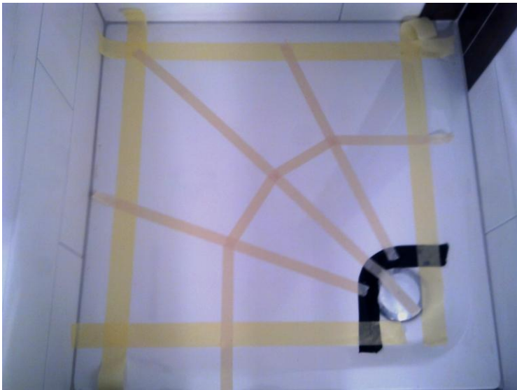
Vorbereitung einer partiellen Anti-Rutsch Beschichtung in einer Duschenwanne
